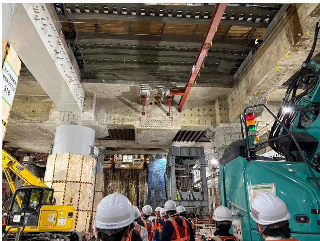
東海道新幹線 品川駅直下の地下の工事現場（直上を東海道新幹線が走行している）
